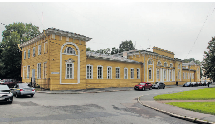
Деревянный флигель-адъютантский дом на Разводной (арх. И.И. Шарлемань, 1834-1838 гг.) - Разводная ул., 1
