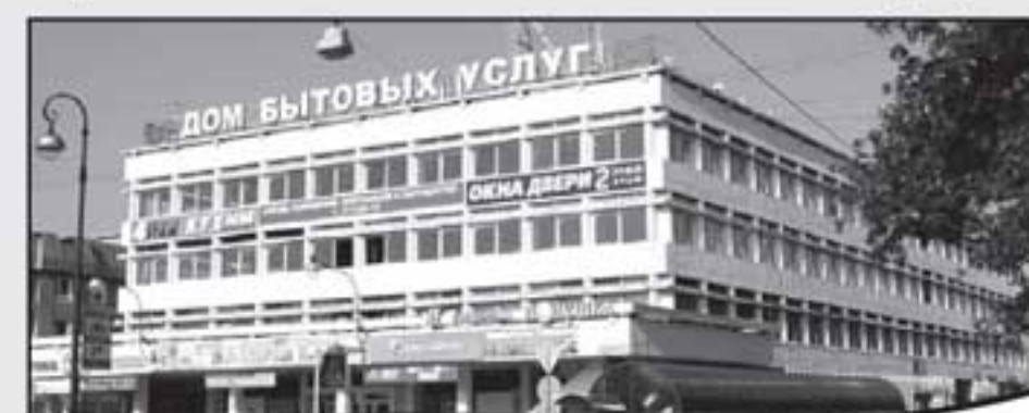
ТОРГОВЫЙ КОМПЛЕКС «КРОНШТАДСКИЙ ДОМ БЫТОВЫХ УСЛУГ»
